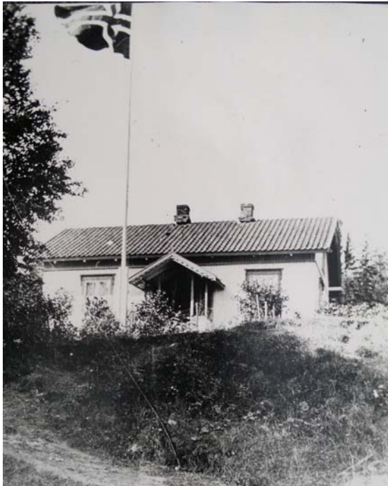
Huset som Martin Hansen bygde etter at det gamle brant i 1900 og fjorden var i ferd med å ta tomten.
