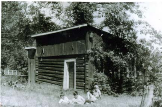
Den laftede stua som ble benyttet som uthus, vinduene på vegg til høyre kan tyde på at stua tidligere er brukt til beboelse.
