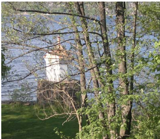
Fyret på Steinbråten sett gjennom vegetasjonen fra veien.
