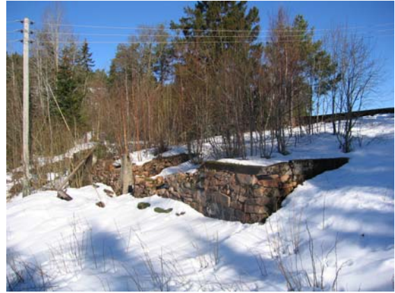
Alt som gjenstår i dag er ruinene av grunnmuren etter Røysjøplassen
