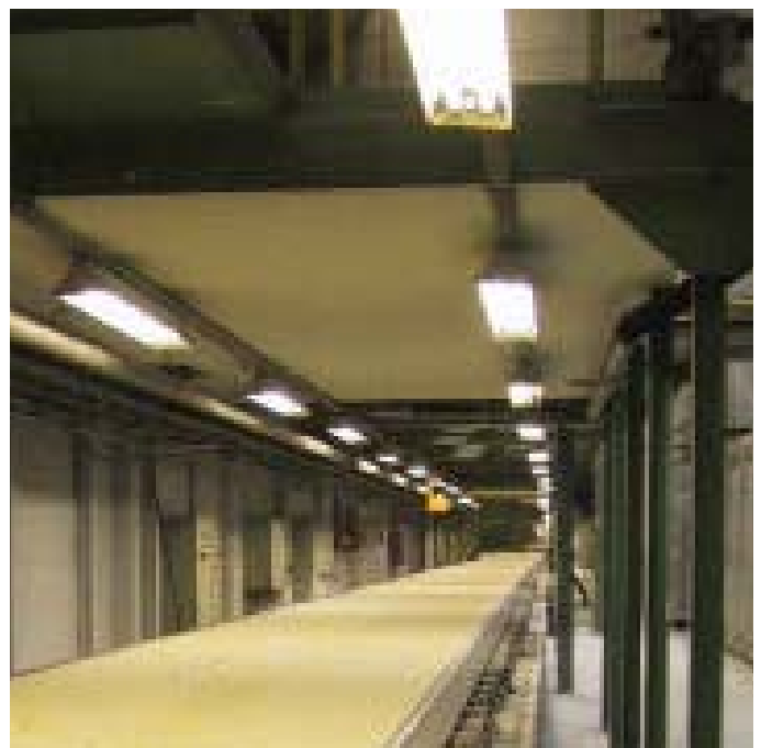
Bandet, produksjonslinja på Tørkop er ca 200 m lang, her produseres det en uendelig lang gipsplate som først kappes i enden av bandet
