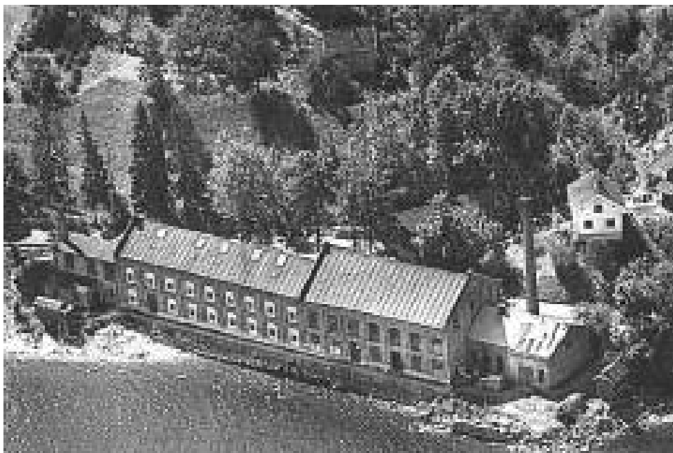
Flyfoto av fabrikken fra 1960. Produksjonslokalene er de to bygningene i midten, til venstre er smie og verksted med turbinrommet under. til høyre fyrrom og pipe som ble bygget på et senere tidspunkt enn hovedbygningene.
