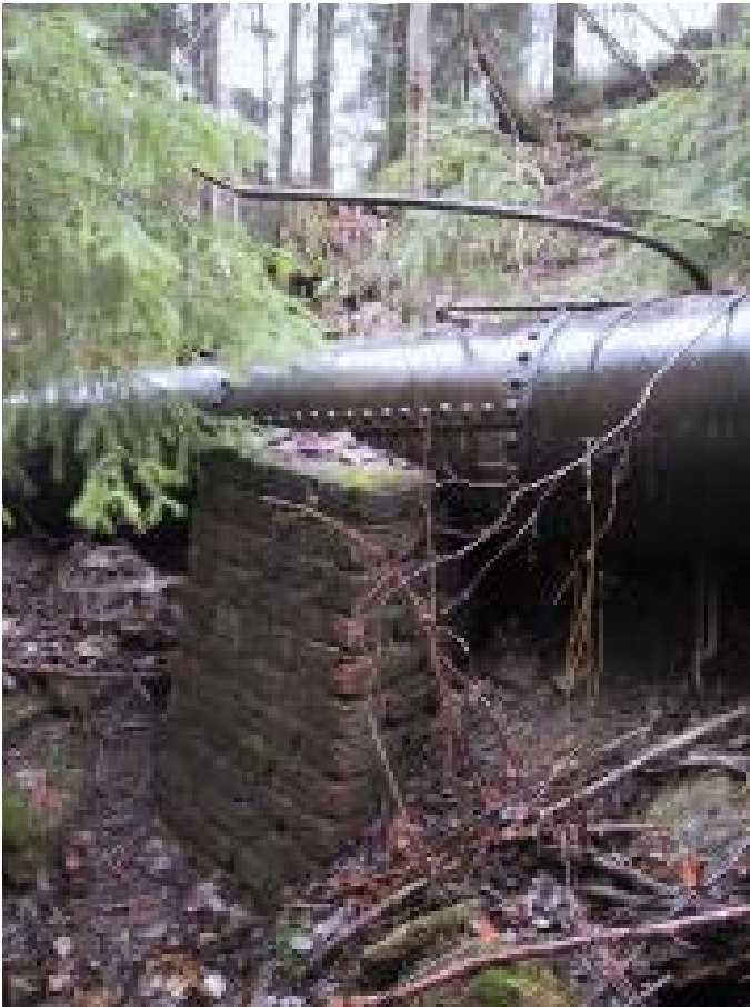
Mye av den klinkede turbinledningen ligger fremdeles i terrenget nedenfor sankedammen. Her ses også et murt teglfundament
