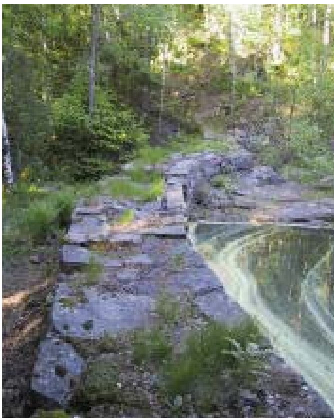
Demning på Mellomdammen
