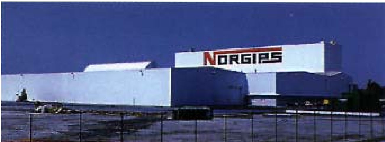
det er dimensjoner over Norgips sitt anlegg i Opole, produksjonslinjen er 500 meter lang, mer enn 3 ganger så lang som linja ved Tørkopfabrikken.
