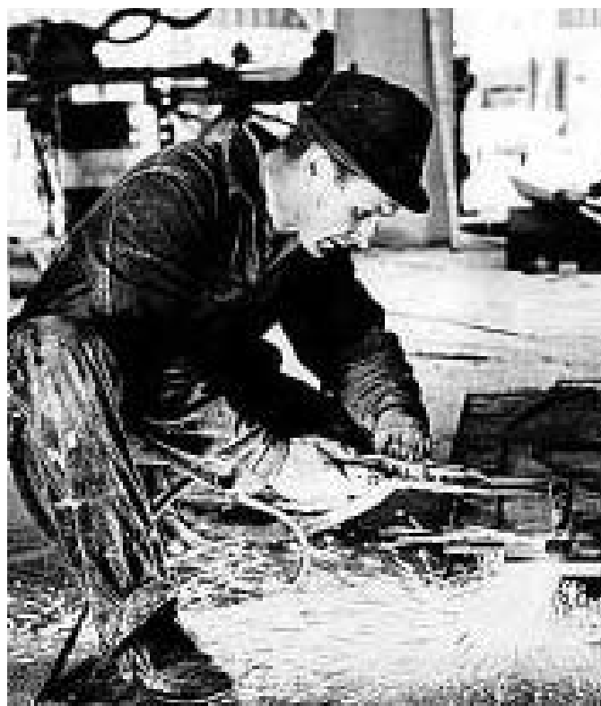
Walter Nilsen i arbeid med installasjonene av maskiner i fabrikken.
